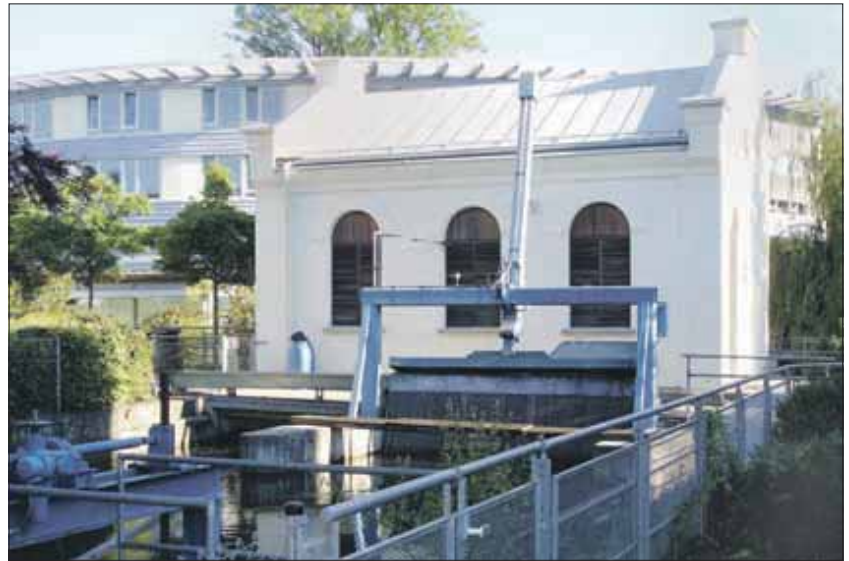
Die Singold speist das 1892 errichtete Wasserkraftwerk im Helsing-Park.
