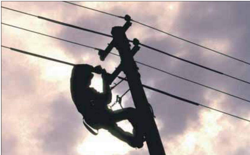
Arbeiten in luftiger Höhe, damit am Boden Kühlschrank und Waschmaschine funktionieren.
