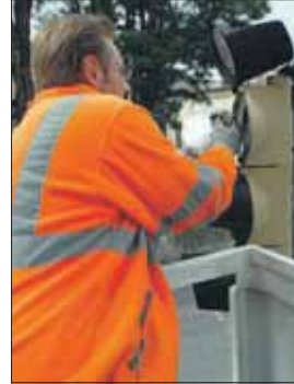
Ampelreparaturen stehen beim Tiefbauamt häufig an.
