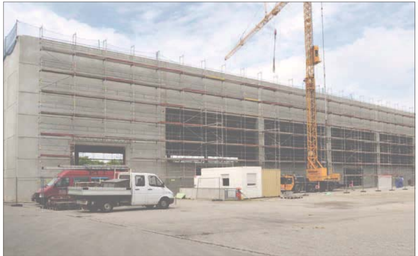
Die neue, rund 10.000 Quadratmeter große Messehalle signalisiert Aufbruchstimmung. Foto: S. Kerpf
