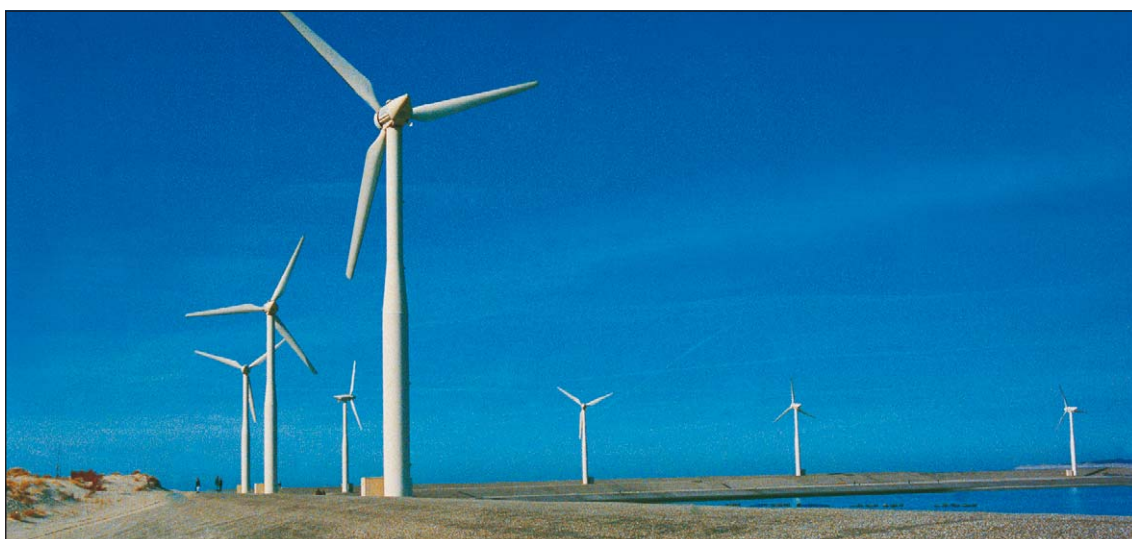
Carbonfasern werden auch für Rotorblätter von Windkraftanlagen verwendet.
