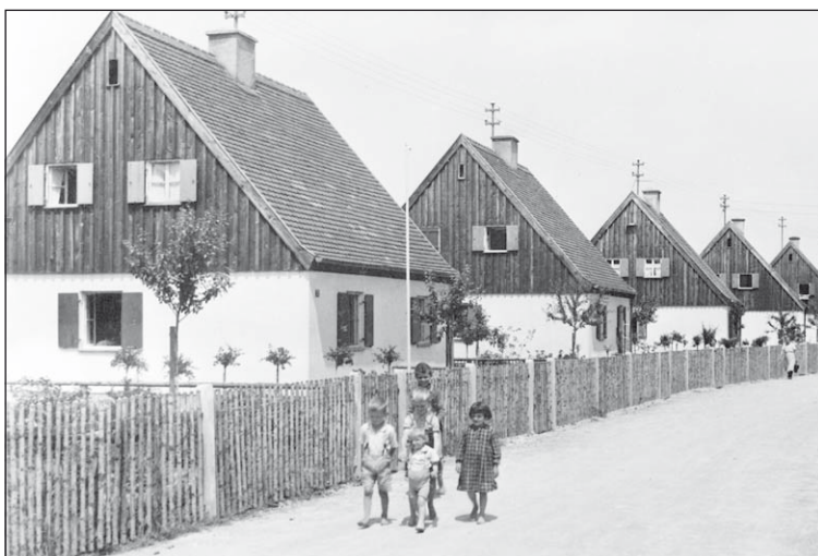
Eine Straße mit Siedlerhäusern im „alten“ Bärenkeller.
