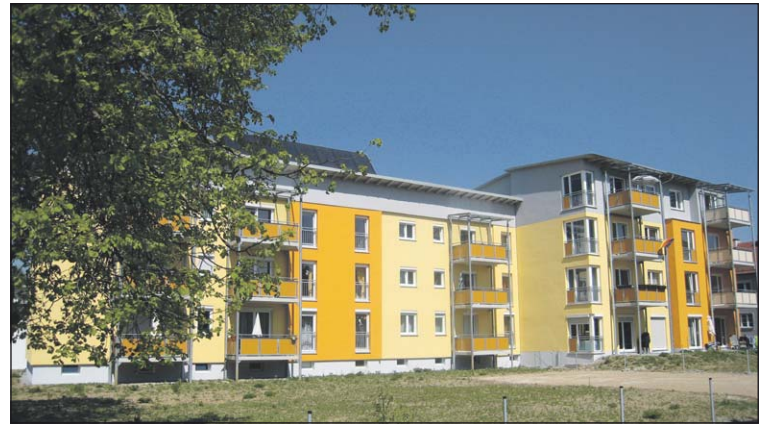
Die energetische Modernisierung der Wohnanlage in der Lützwitzstraße 31 und 31 a der WBG gilt als vorbildlich. Foto: WBG
