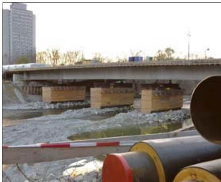
Ein wichtiges Verkehrsprojekt ist in vollem Gang und wird 2009 rund fünf Millionen Euro kosten: die Ulrichsbrücke. Foto: Kerpf
