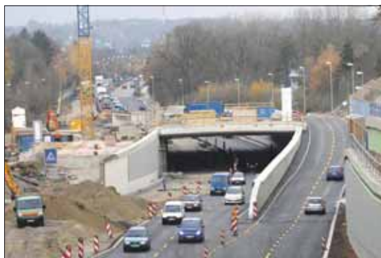
Im Frühjahr 2008 wird die B 17-Kreuzung Gabelsbergerstraße für den Verkehr freigegeben. Anschließend wird die Kreuzung Leitershofstraße ampelfrei ausgebaut.
