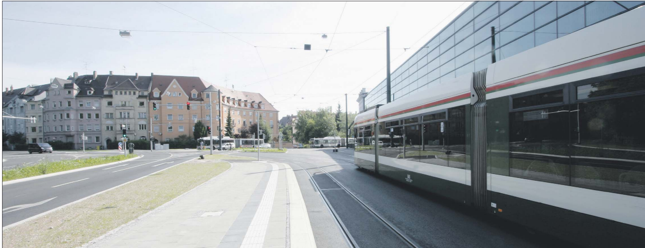
An der Kreuzung Rote-Torwall-Straße/Friedberger Straße/Remboldstraße fließt der Verkehr bereits wieder normal.
