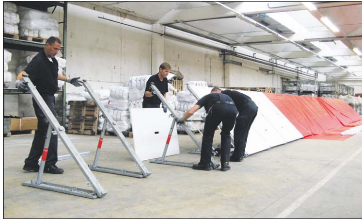
Flexibel einsetzbar: die Hochwasserschutzwand. Foto: Friedhelm Bechtel
