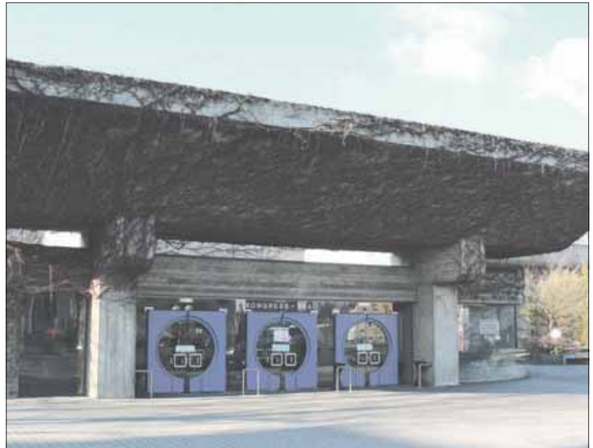
Die Kongresshalle soll grundlegend saniert und dann als Tagungszentrum unter anderem auch für Großkongresse genutzt werden.
