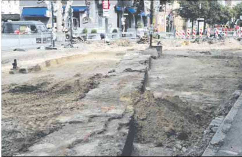
Bei der Sanierung des Straßenbelags am Klinkertor kam bereits 30 Zentimeter unter der Oberfläche historisches Mauerwerk zum Vorschein. Foto: Siegfried Kerpf
