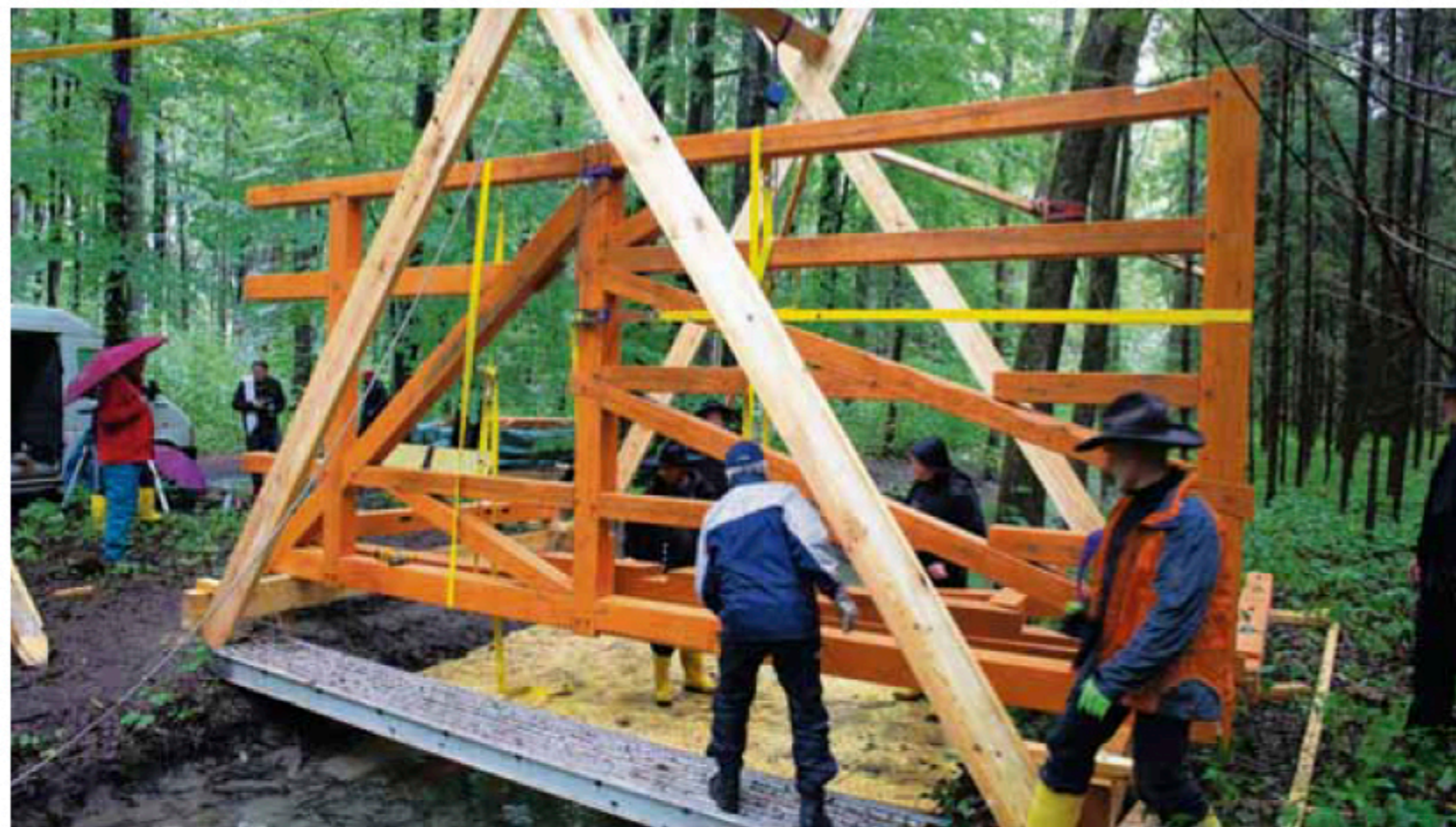
Keine Brücke, sondern eine Kunstinstallation setzten die Zimmerleute in Fachwerk aus Eichenholz im Stadtwald über dem Reichskanal zusammen. Foto: Michael Hochgemuth
