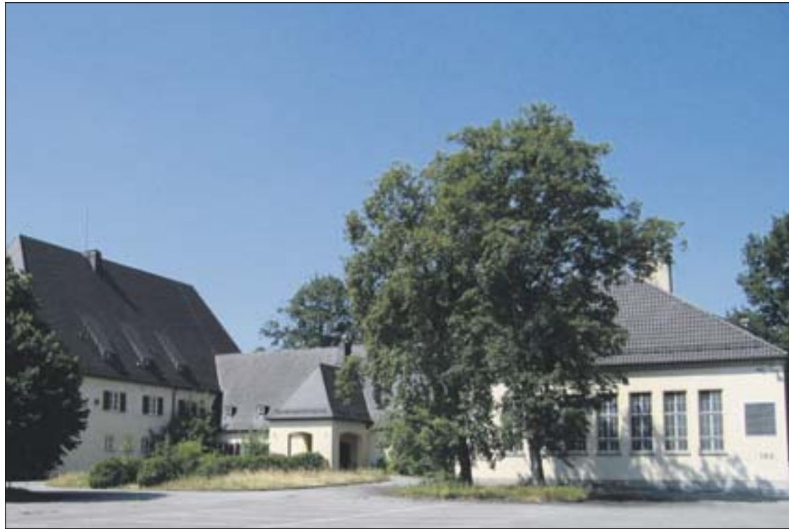
Das ehemalige Kasino auf dem Sheridan-Areal.
